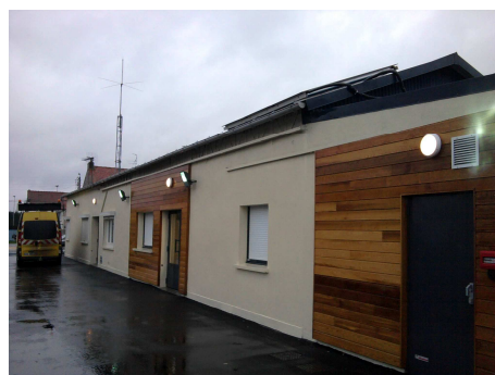
Rénovation des façades du bâtiment existant
